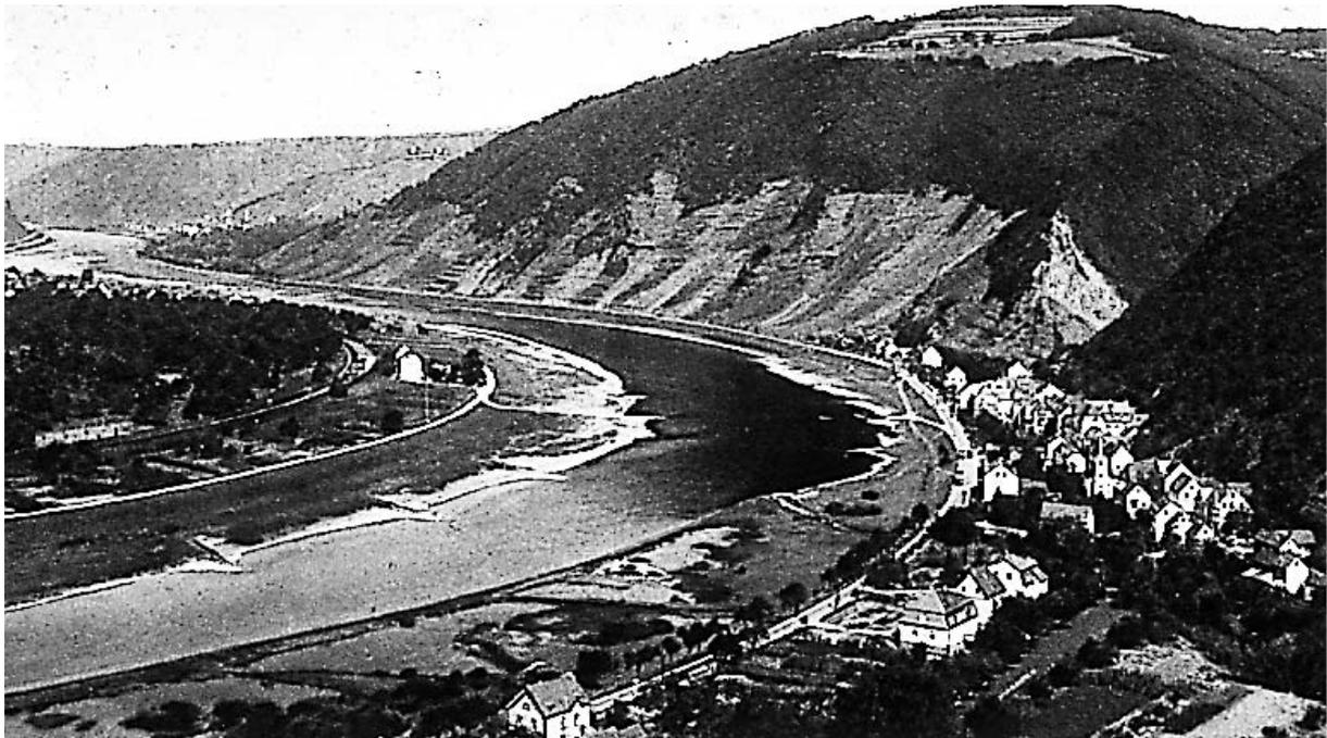
**Brodenbach um 1930:** Der Damm der rechten Moselseite ist aus der Zeit der Flußregulierung der 1830er Jahre. Dahinter die Stillwasserbereiche, *Kümpel* genannt. Von der Löfer Seite ragen gemauerte *Krippen* in den Fluß. Mit Damm und Krippen erreicht man einen höheren Wasserstand in der flachen, aber schnell fließenden Flußpartie, auch *Rausch* genannt.
